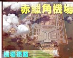
香港機場核心計劃 HONG KONG AIRPORT CORE PROGRAMME NAFCO
